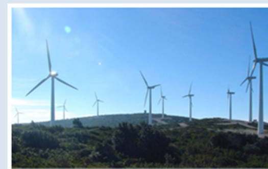
Parc de TUCHAN Département : Aude (11) Puissance électrique : 11,7 MW 18 éoliennes Mise en service : 2001-2002-2009
