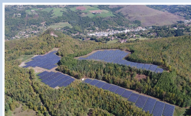
Centrale Solaire de DECAZEVILLE-AUBIN Département de l'Aveyron (12) Puissance électrique : 12 000 KWc Mise en service : Décembre 2016
